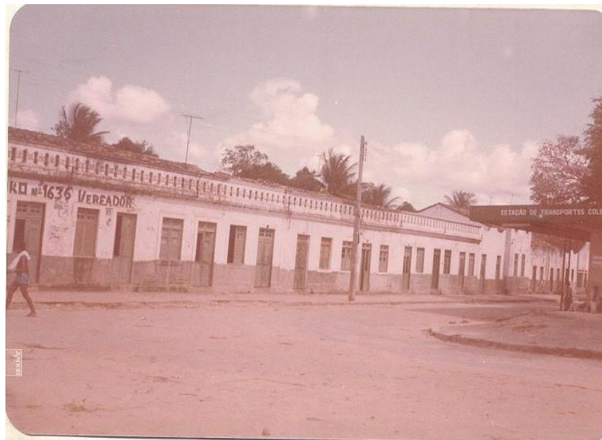
Figura 24 – Casas com platibandas na Praça São José.
