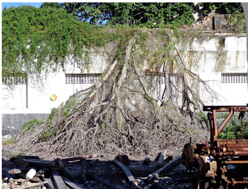
Figura 40 – Imagem interna da edificação da Fábrica Carmen.
