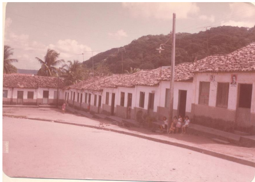
Figura 21 – Rua Dr. Pontes de Miranda, conhecida como “Vila Operária”.
